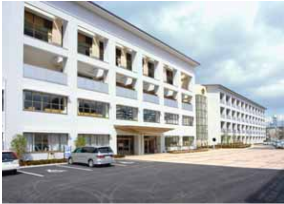
▲管理棟(左)と教室棟(右)。管理棟正面玄関向って右側が事務室です。
