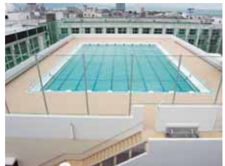
▲体育施設棟の屋上には水球競技も可能な深さを持つプールが完成。
