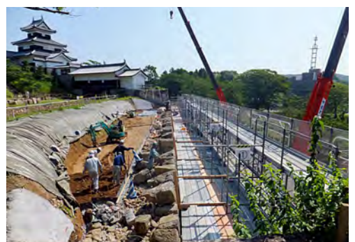
石垣積み替え中の本丸南面
