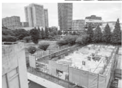
◀2022年7月 管理研究棟 屋上から正門方向を望む
