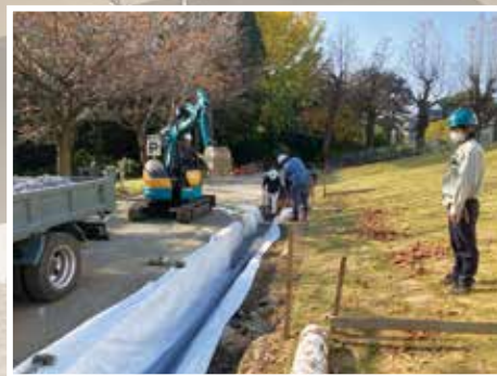
写真1 工事中の雨庭（2020年11月17日撮影）
