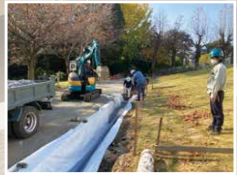
写真1 工事中の雨庭（2020年11月17日撮影）
