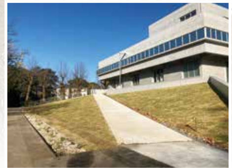
写真2 竣工した緑のテラスと雨庭（2020年11月28日撮影）
