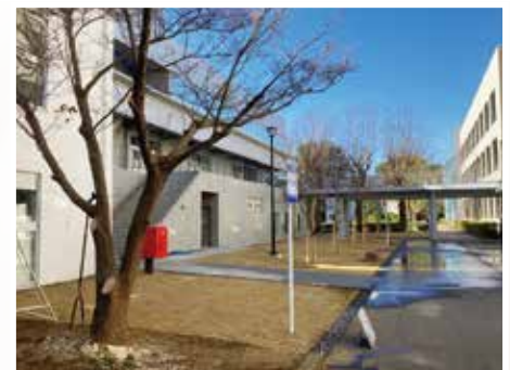
写真3 植栽工事を終えた北側外構（2020年12月17日撮影）
