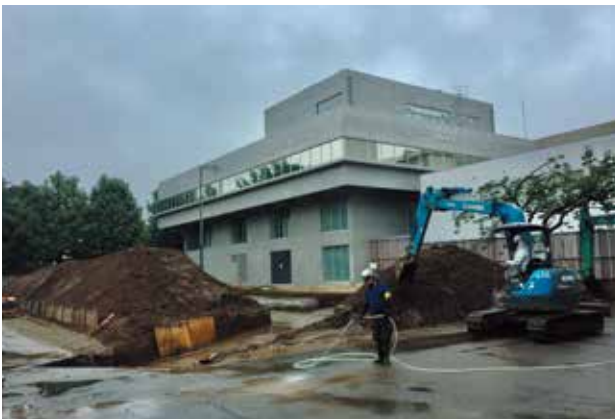
写真1 工事中の緑のテラス (令和2年7月16日現在)
