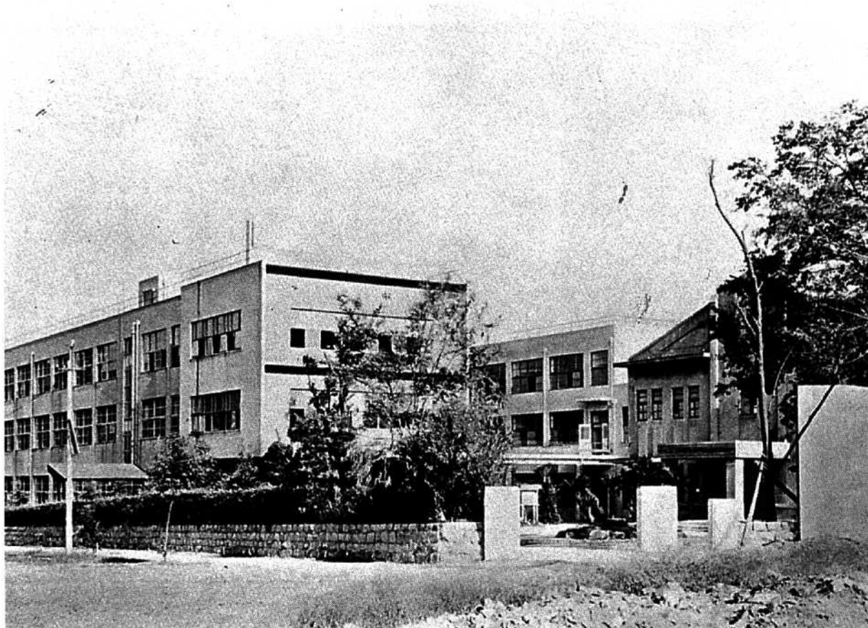
▲ 整備されてきた崇徳中・高等学校。左側と中央が新築された1、2号館。右は被爆後に修復された講堂。（昭和34年「広島私学」より）
