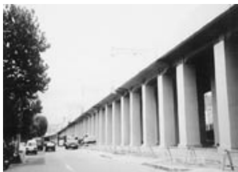
補修完成 写真 3
