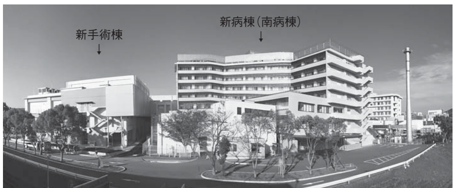
本院東側からの眺め（新手術棟と新病棟[南病棟]）
