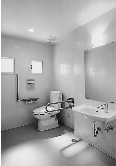
洗面所は男女別（写真は女子洗面所）、車椅子の方も楽に使っていただけるように広いスペースをとり、補助手すりを採用しています。
