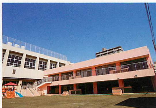
園庭から見た新園舎(左は体育館)
