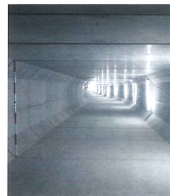
道路下の柿川放水路内部(片側)
