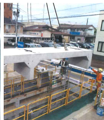
柿川放水路 道路下に函渠埋設
