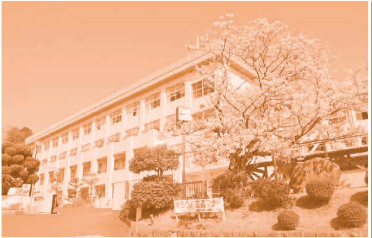
〈耐震補強工事後の1号館〉
