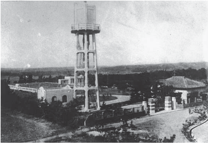
昭和6年 運動場北 上水場の給水塔
