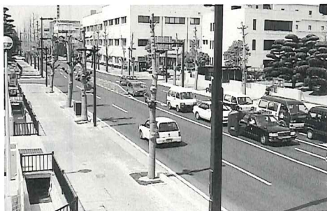
前号で紹介した「市役所前から電柱が消える」が完成し、写真のように電線がなくなりました。
