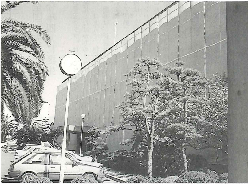
外壁改修工事中的の本館
