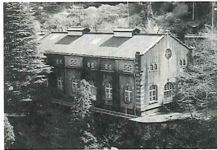
貴重な発電装置の遺る旧端出場水力発電所
