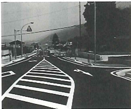
完成した上部東西線第2期区間
