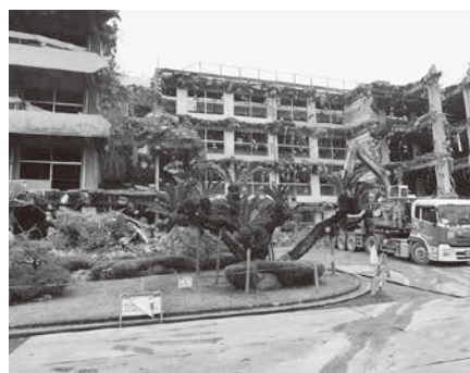
本館の解体工事（正門前から撮影）
