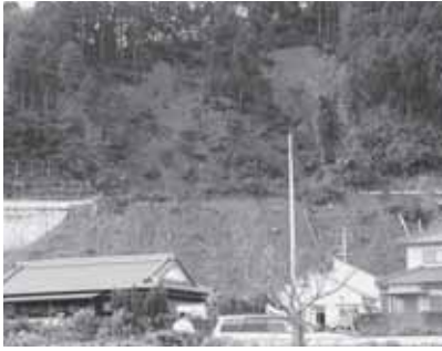
高速道路南側の山崩れ(大生院地区)
