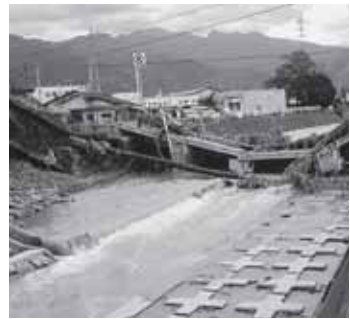
流失した滝の宮遊歩道
