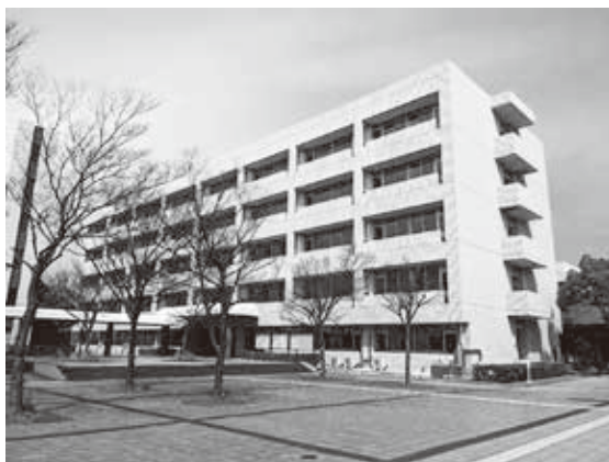
22年春に大規模改修工事を終えた経済学部棟 （現在の名称は、西3号館）
