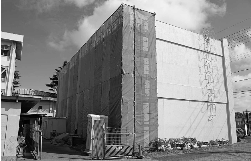
改修工事中の武道場
