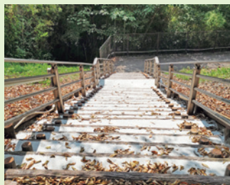
階段の踏面が コンクリート打設されている。
