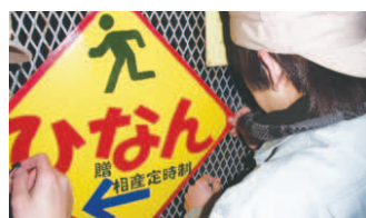
製作した避難誘導標識を自治会内に設置
