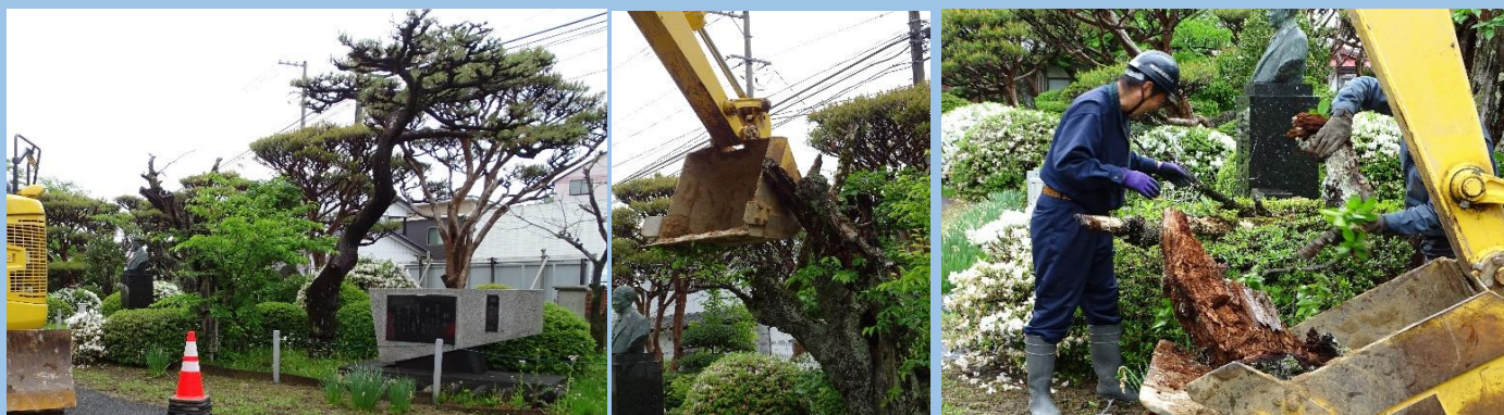
撤去作業の様子
